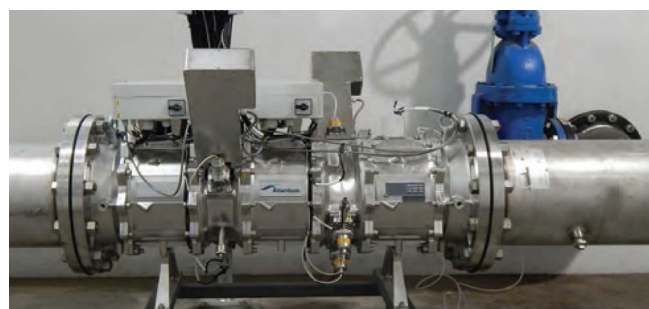
Instalação Atlantium HOD UV na represa Parker, EUA
